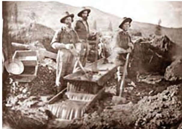
شکل ۱۱.۳ عبور آبرفت رودخانه‌ای از روی سطح شیب‌دار با موانع برای گیرکردن ذرات طلا
