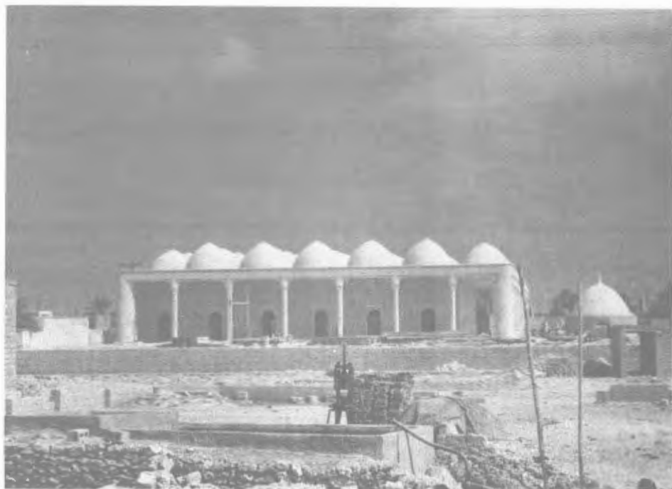
مسجد معروف قشم در شمال جزیره که در کنار آن آب انبار دیده می شود.
